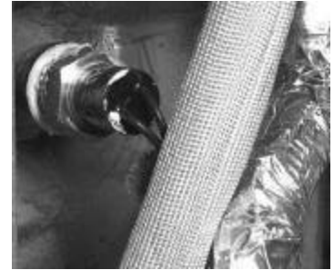
Fig: 10-18 Hi-limit probe
