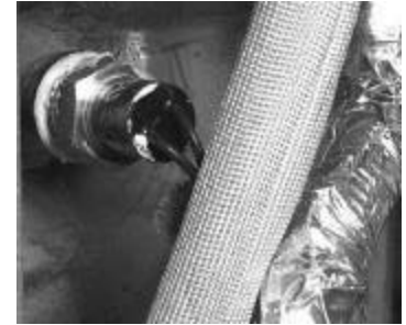
Fig: 10-18 Hi-limit probe
