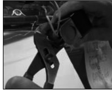
Loosening the conduit nut
