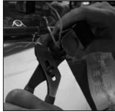
Loosening the conduit nut
