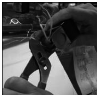
Loosening the conduit nut
