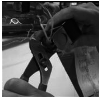
Loosening the conduit nut
