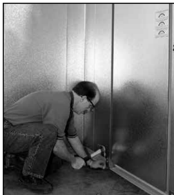
Instale el anclaje
